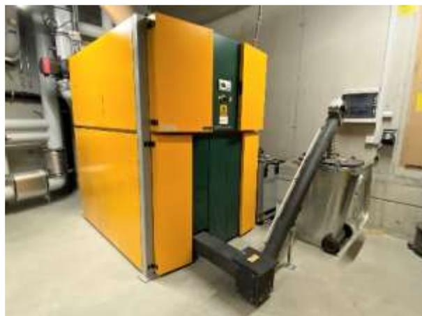
Die Anlage ist zudem mit zwei Trocken-Elektrofiltern ausgestattet, welche den Feinstaub auf ein Minimum reduzieren. Zwei Wärmespeicher von je 5'500 Liter sorgen dafür, dass die Pelletheizungen stets in der optimalen Leistungsstufe arbeiten. Über ein Fernleitungsnetz fliesst die Wärme zu den 35 Wohneinheiten.
